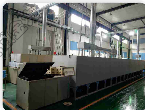
5 氧化锌元件隧道窑生产线
